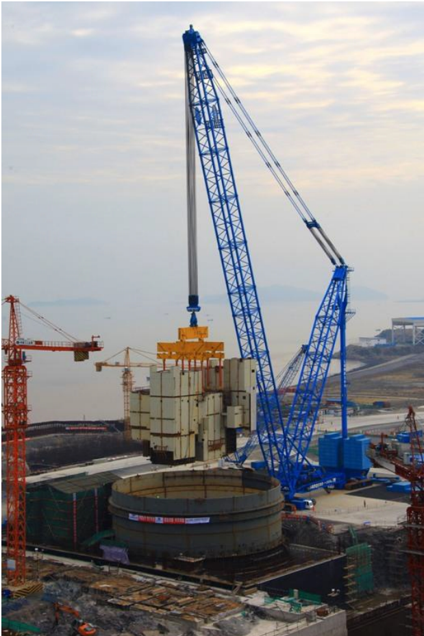
Inlyft av en 700 ton tung förtillverkad modul i den kinesiska reaktorn Sanmen 1 i mars 2010. Bild från Westinghouse.
