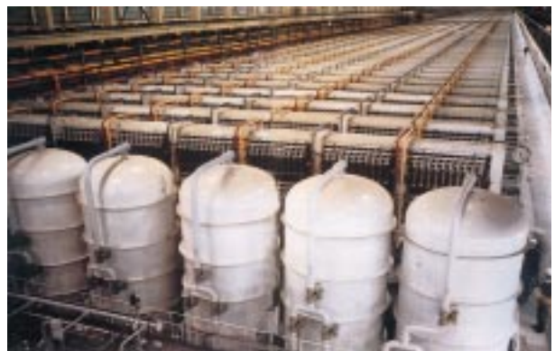
Hall med gascentrifuger
