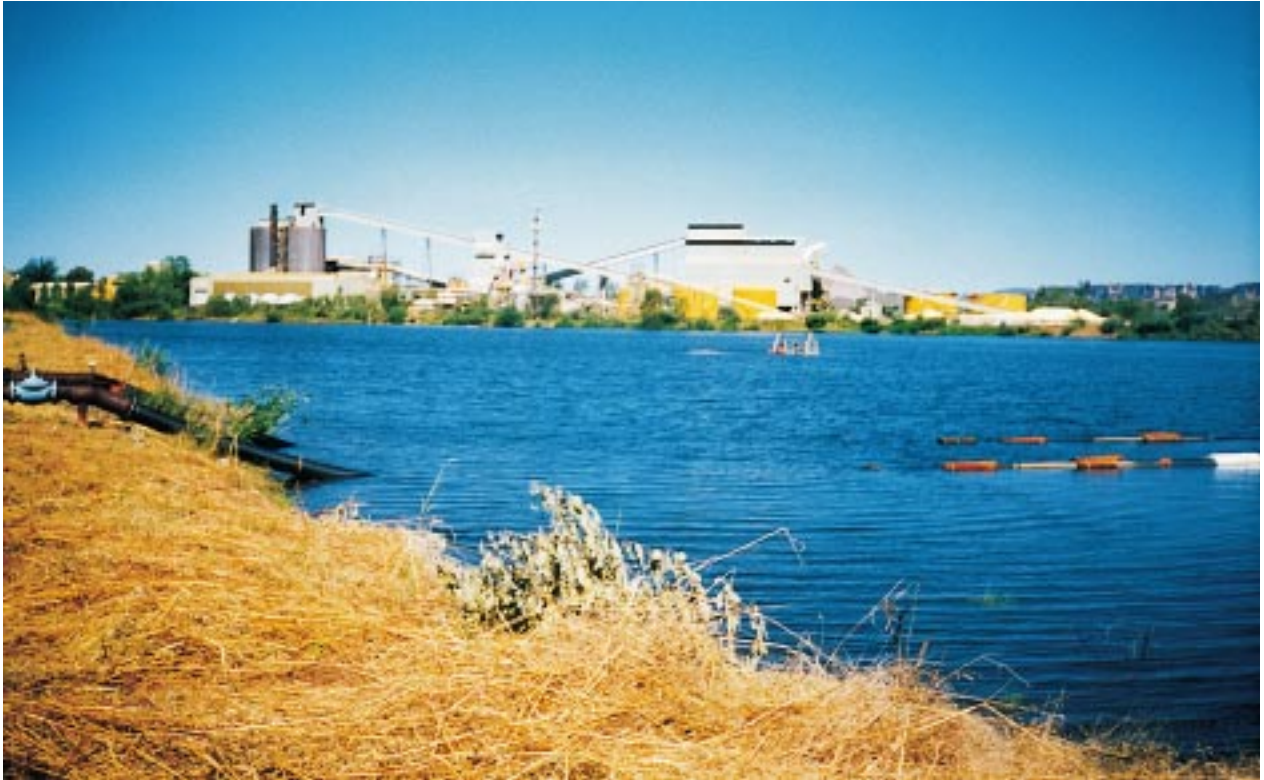
Uranverket med en vattendamm i förgrunden
