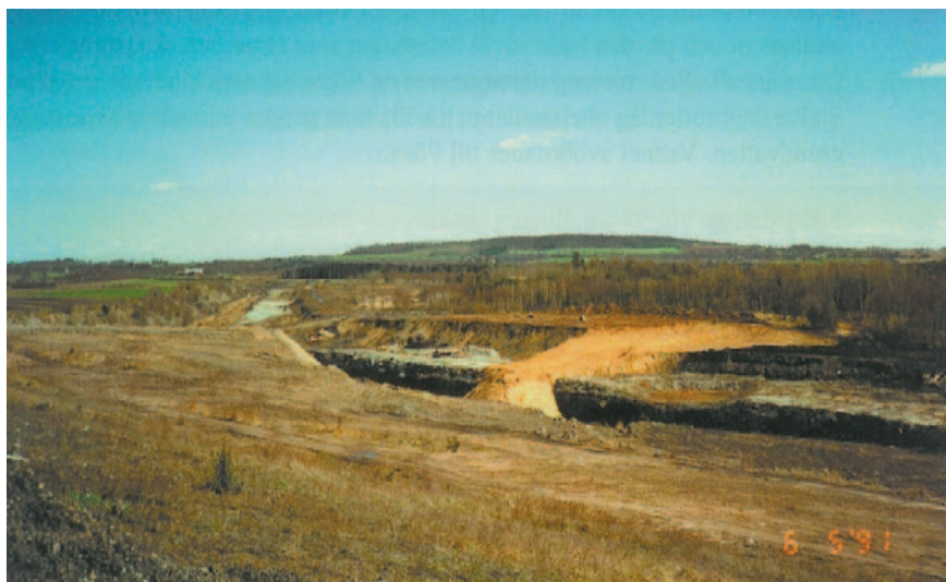
Dagbrottet i Ranstad under pågående efterbehandling
