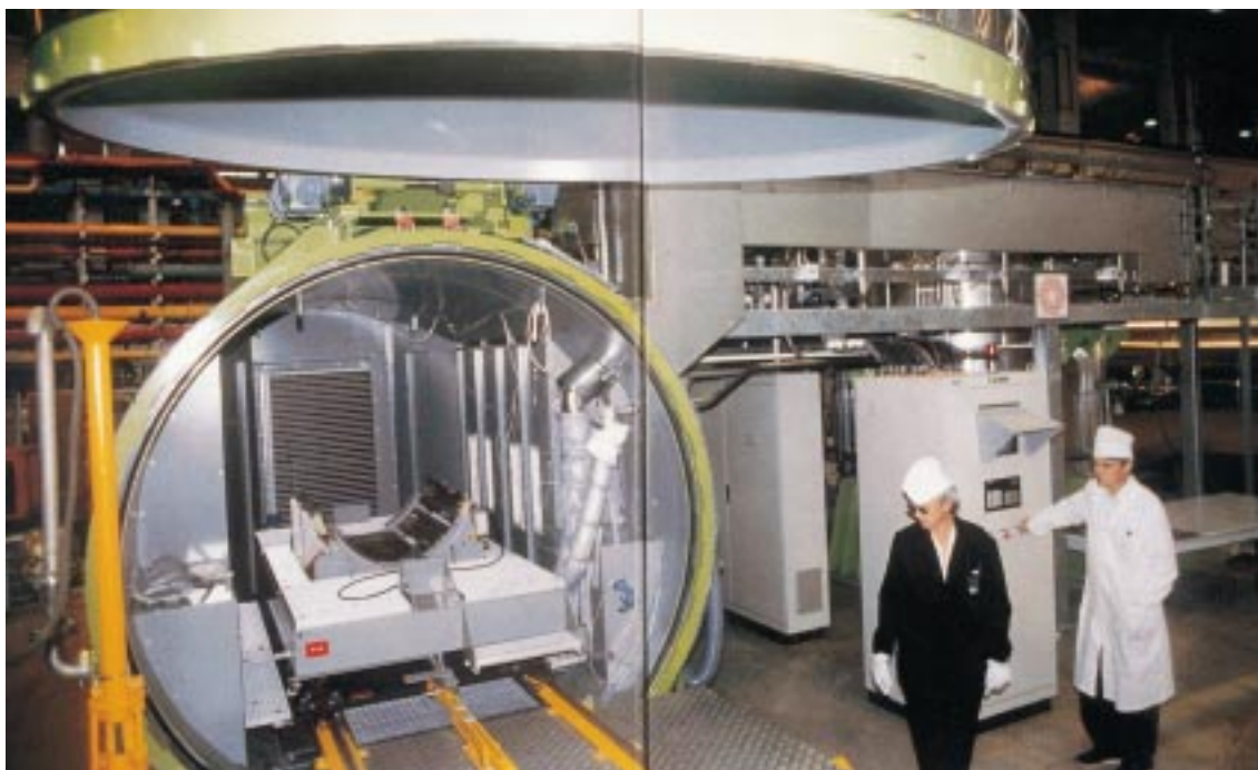
Fyllningsstation för uranhexafluorid i Zelenogorsk. Av säkerhetsskäl sker fyllningen inne i en autoklav varvid man undviker risk för läckage av uranhexafluorid.
