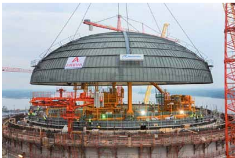
Bild 1. Olkiluoto 3. Reaktorinneslutningens kupol lyfts på plats. Bilden togs september 2009.
